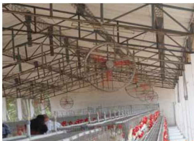
図5. 循送ファンや細霧器を使用して鶏舎内の風速を上げ冷却効果を作り出す。
