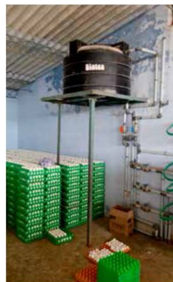
図4. 水を冷たく保つために鶏舎内に設置された水タンク
